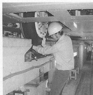
▲リニア車両の出庫前点検作業
