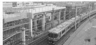
▲中央本線勝川駅付近高架化
