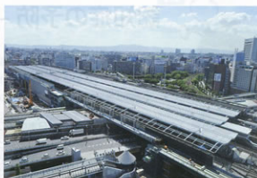
▲27番線ホーム桁架設が完了した新大阪駅
