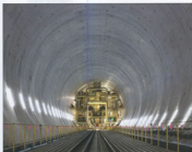
▲シールドトンネル内部
