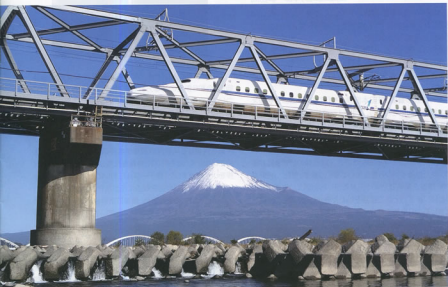
▲富士川橋梁を渡る新幹線 静岡地本 藤崎支部 星野 滋
